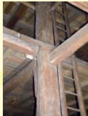
Baugeschichte: Firstständer in der
